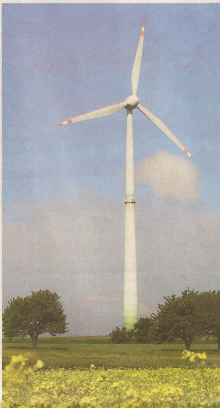
Die Kasberger Windkraftanlage mit einer Nabenhöhe von „nur“ 98 Metern. Die neuen Anlagen im Raum Gräfenberg sollen um die Hälfte höher werden.
